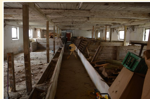
Oprydning og nedbrydning af gamle grisebåse
