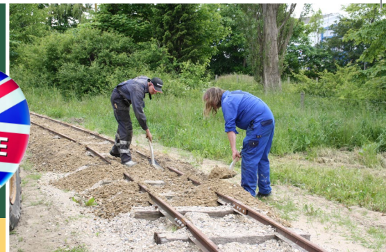
Anlæg af smalsporsbanen 2014
