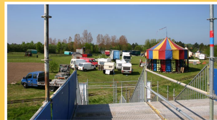
Stilladsbro opføres over banen
